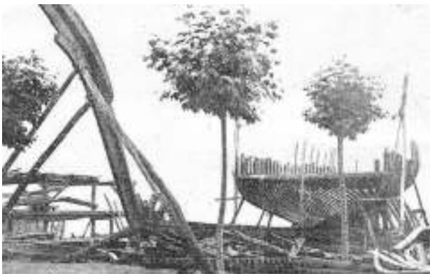
Construcció d'un bastiment als sorralis del nostre litoral
